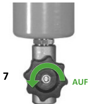
Kondensatableiter Typ CDM15/50N
